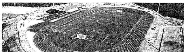
小野希望の丘陸上競技場アレオ全景(小野市都市施設管理協会HPより)
